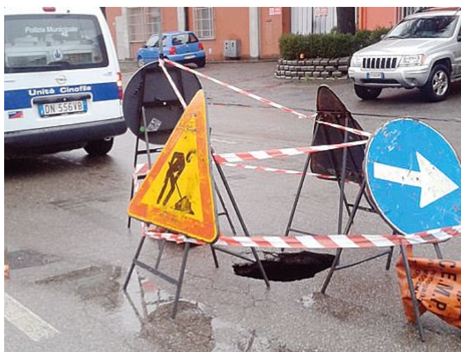
Una buca divenuta più profonda a causa delle piogge
